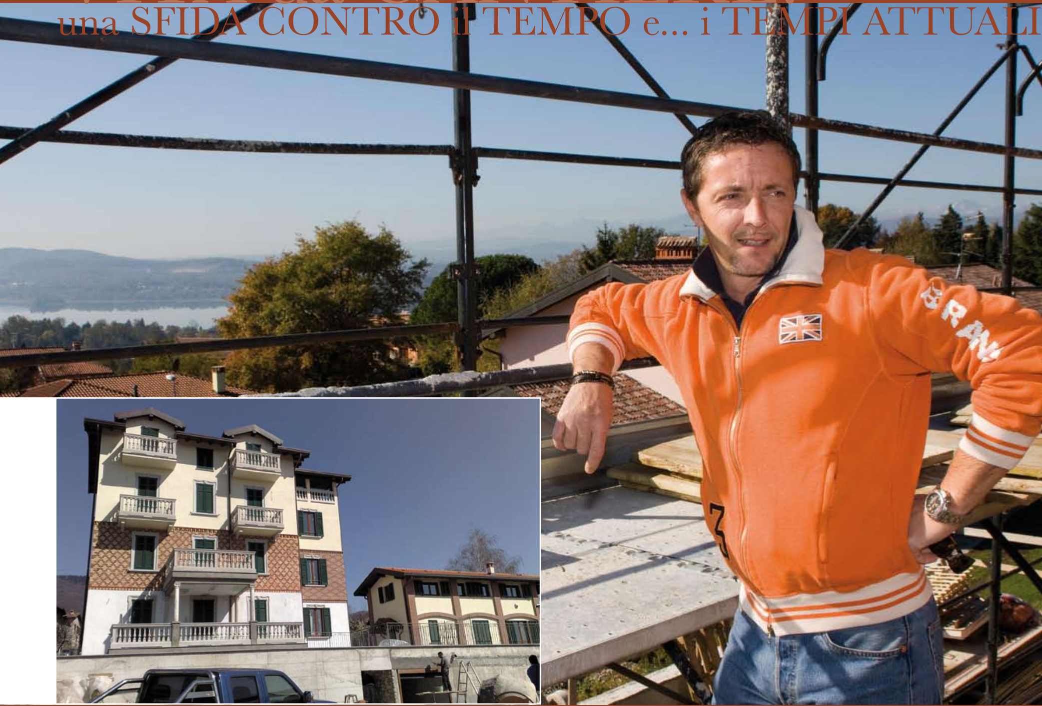
Fra queste, una villa prestigiosa del 1900 a Barasso, con stupenda vista sul lago di Varese, ristrutturata completamente con ampliamento e nuova costruzione in stile.
